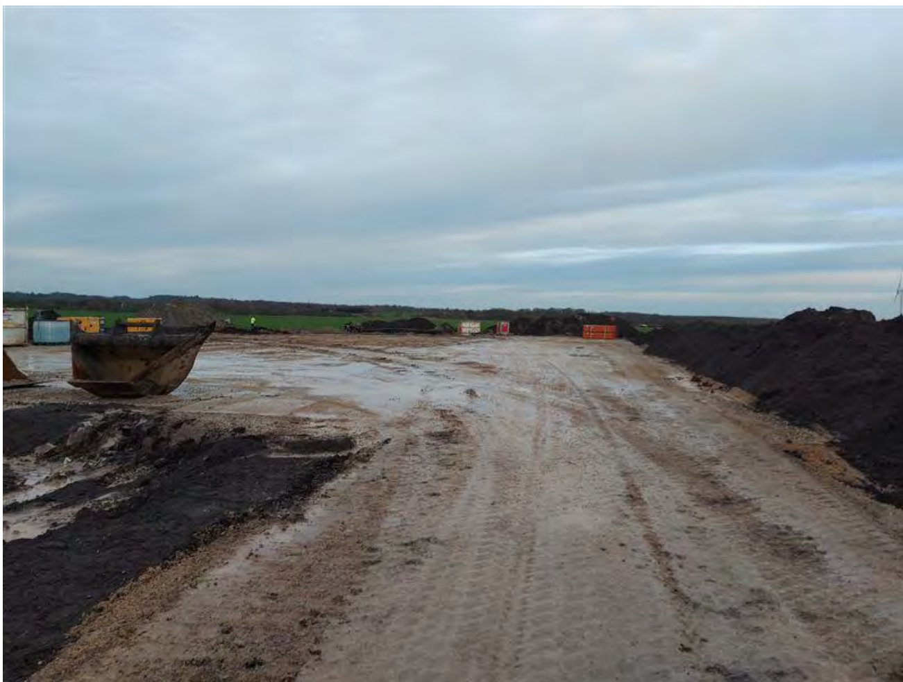
Foto: Eksempel på etablering af adgangsvej med stabilgrus og kranplads omkring en kommende vindmølle.
