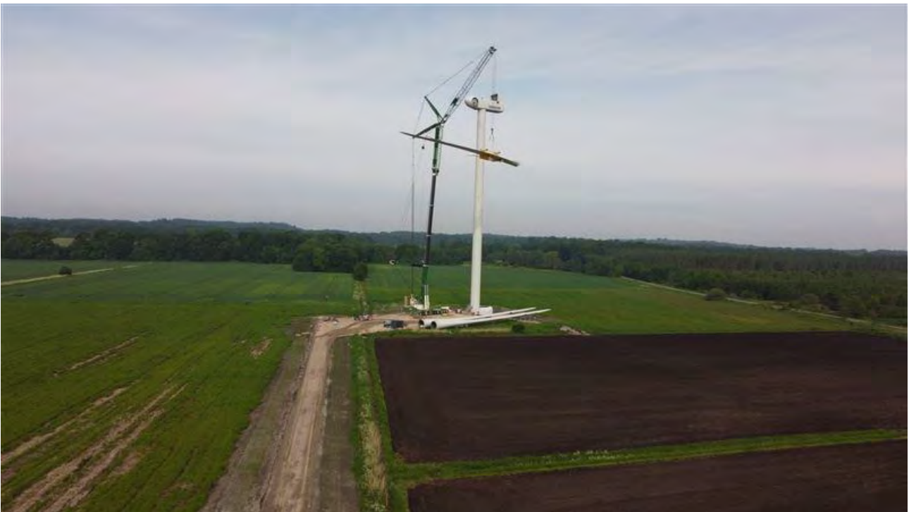
Foto: Arbejdsplads med kran under løft af vinge til en Vestas vindmølle.
