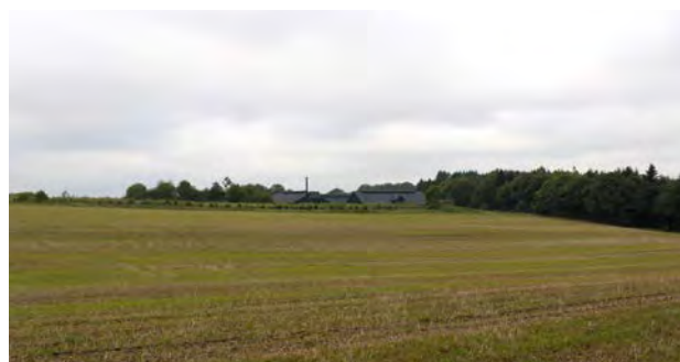
8. Landbrugsbygninger ved Rørbæk, som er fint indpasset i landskabet.
