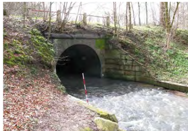
3. Fredet bro under Gl. Koldingvej - FOTO: Kulturministeriet
