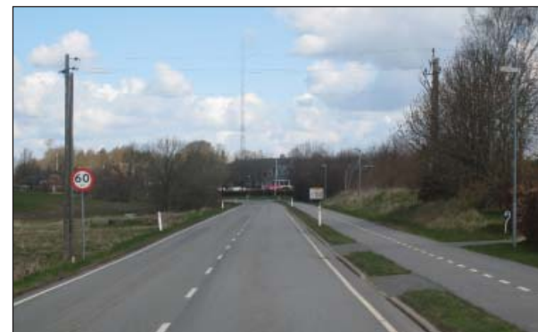
Vongevej ved Engvej, set mod nord
