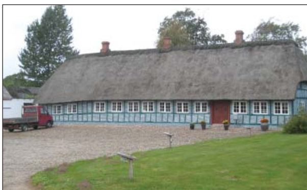
Stuehuset på Ødegård
