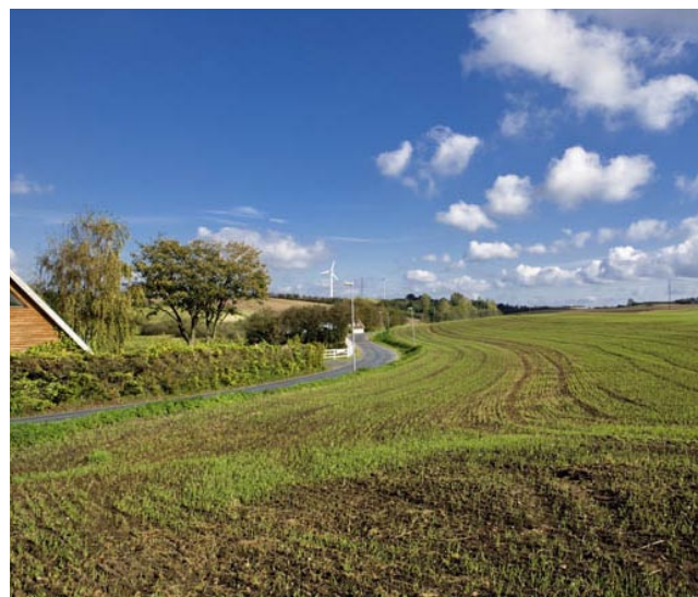
Tilslutningspunktet ved Høgsholtvej, set mod øst. Terrænfoto nr. 6.
