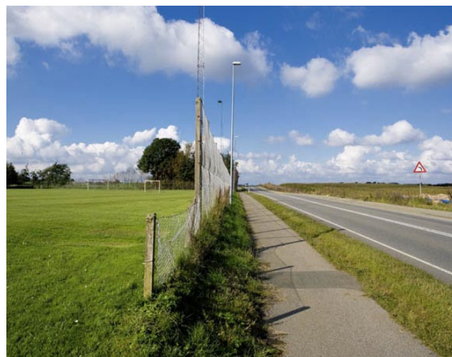
Tilslutningspunktet ved Jellingvej, set mod nordvest. Terrænfoto nr. 3.
