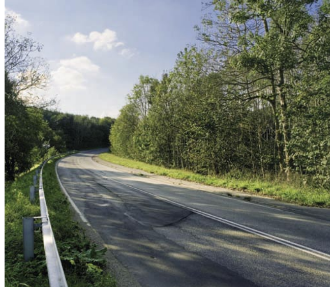
Tilslutningspunktet med Vardevej, set mod vest. Terrænfoto nr. 10
