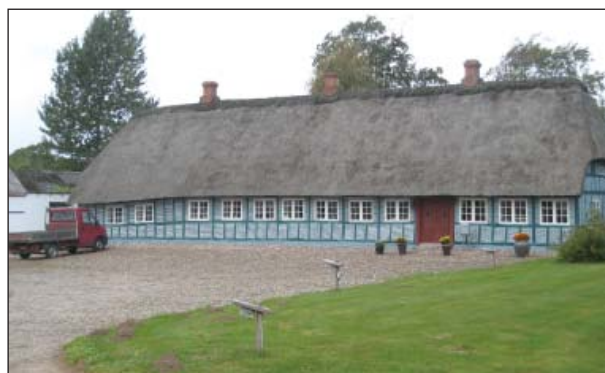
Stuehuset på Ødegård
