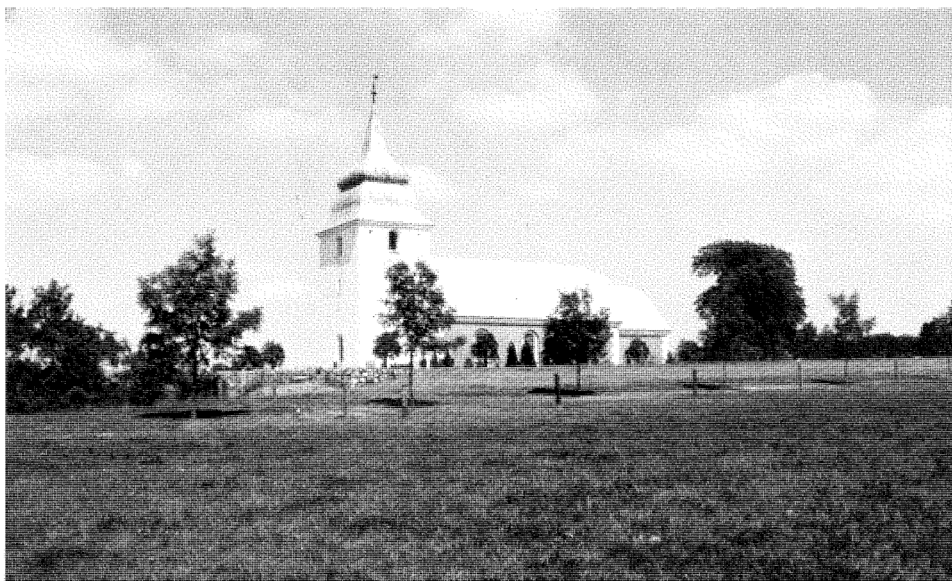
Hatting kirke er, som kirken i Nørup og Bredsten samt Engelsholm Slot, ombygget i slutningen af 1700-tallet med løgformet spir på initiativ af storkøbmanden de Lichtenberg fra Horsens. Selv om Hatting er vokset kraftigt i vor tid, er kirkeanlægget fritliggende midt i byen. Her set fra syd.
