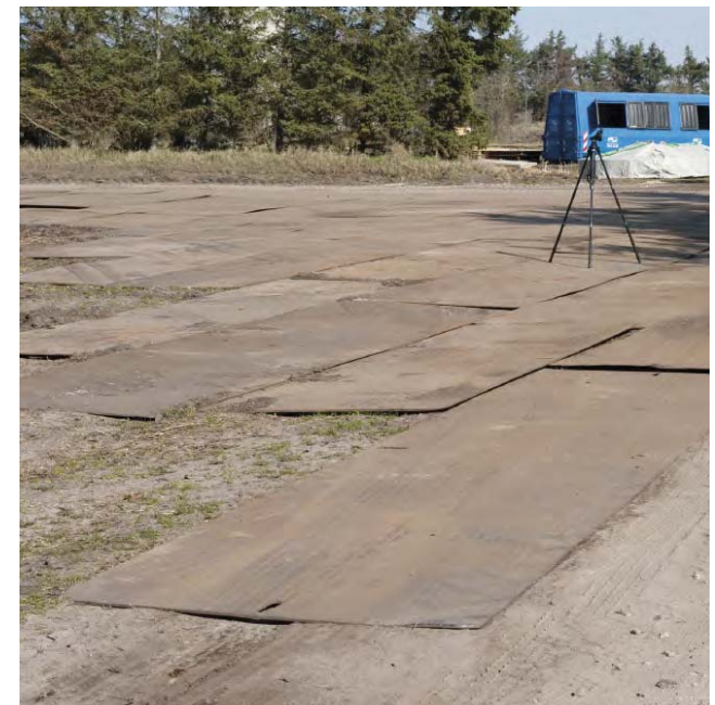
Foto 3.3 Sving på arbejdsvej af jernplader.
