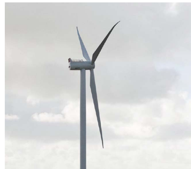
Foto 3.2 Møllehus på en gearløs vindmølle. Tårnet er placeret midt på møllehuset.
