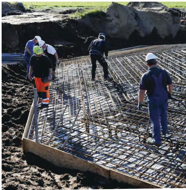
Foto 3.5 Støbning af pladefundament
