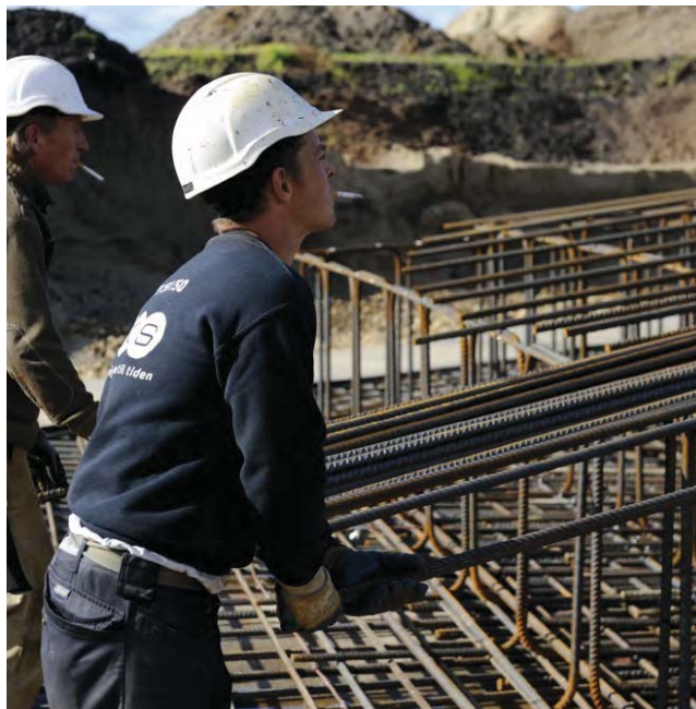
Foto 3.4 Oplægning af armering til pladefundament
