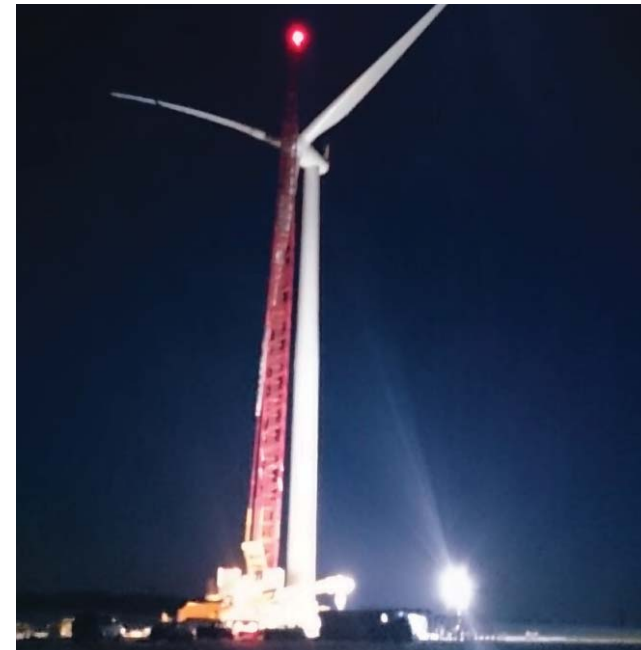
Foto 3.6 Installation af vindmølle, aften-/natarbejde
