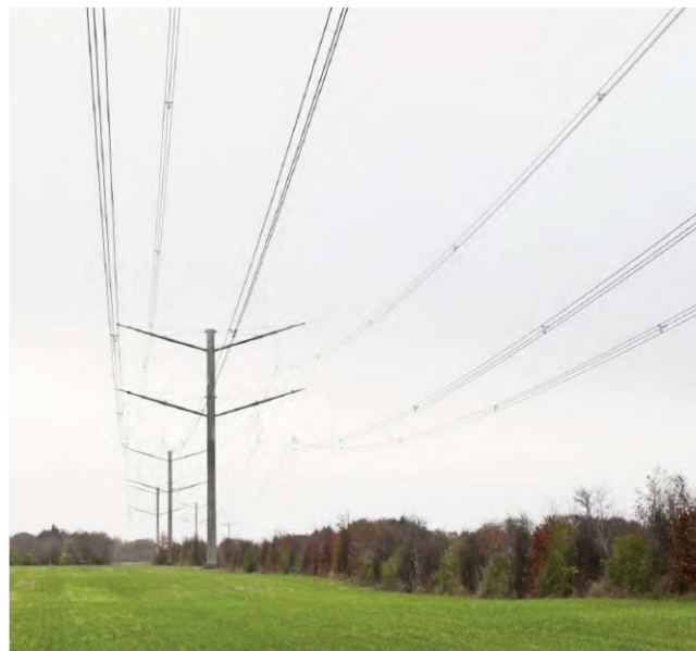
Foto 5.9 2x400 kV-højspændingsforbindelse. Set fra Ågårdvej mod syd i retning mod vindmølleområdet.
